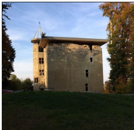
Après, état fin 2018
