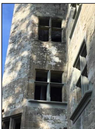
Exemples de restauration des encadrements de fenêtres
