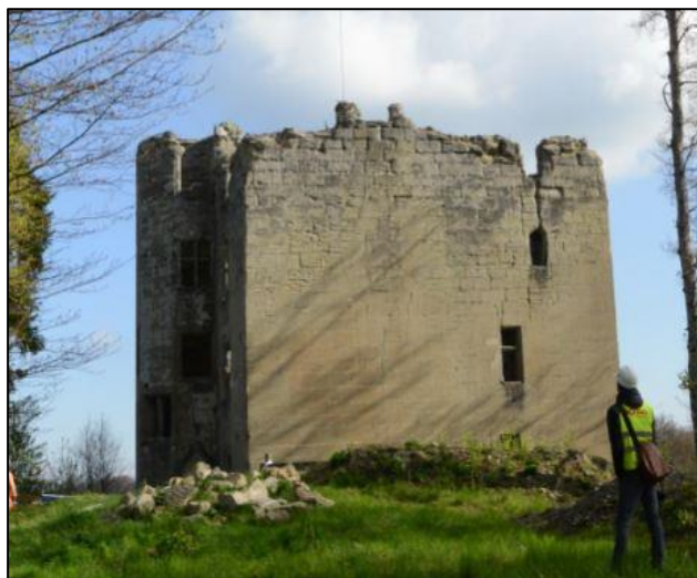
Avant les travaux de préservation
