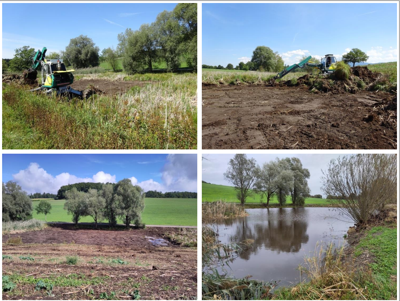
Curage d'une partie de l'étang Dailles, à Magnedens, à la fin de l'été 2022 dans des conditions sèches. L'étang s'est rapidement rempli sitôt les premières précipitations. Photos : G.Schaub
